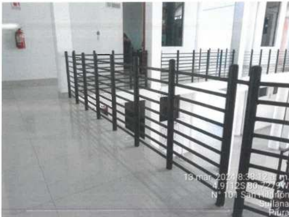
Pintado de barandas de rectorado
