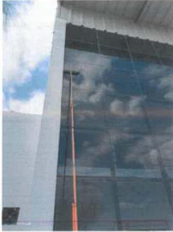
Se realizó la limpieza de muros externos
