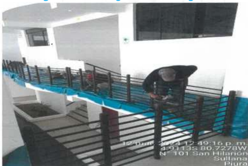
Instalación de plástico para pintado
