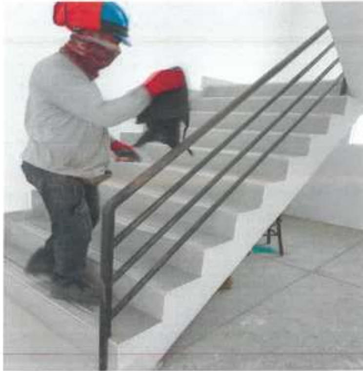
Se realizó la limpieza de barandas de escaleras
