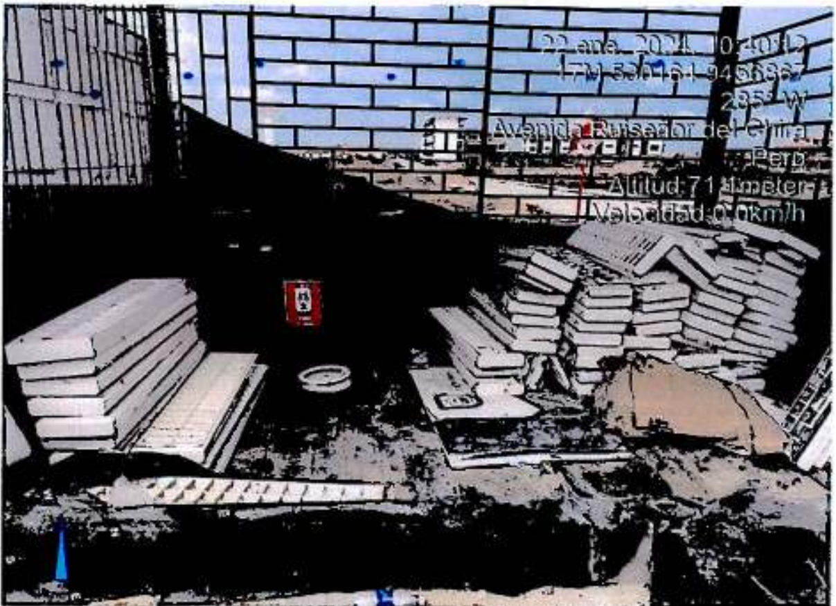
Ilustración 32. ESTADO ACTUAL DEL CENTRO DE ACOPIO DE LA UNF
