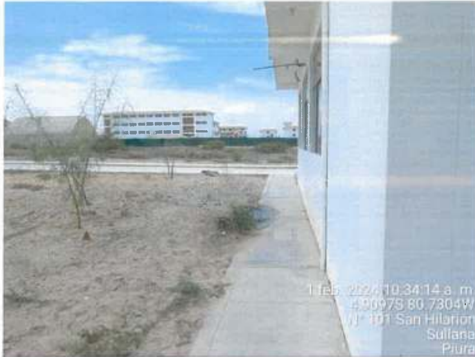
Se verificó desmonte en el exterior de parque tecnológico
