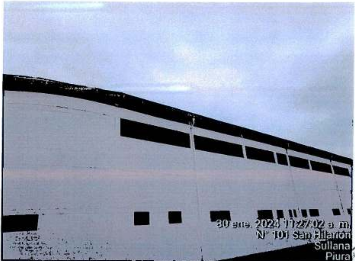
Ilustración 5. SERVICIO DE MANTENIMIENTO Y LIMPIEZA DE CANALETAS DE LA UNF
