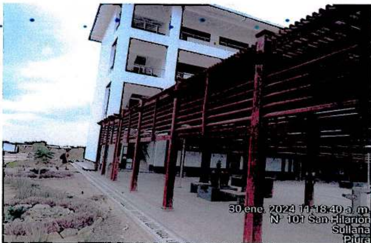
Ilustración 20. SERVICIO DE MEJORAMIENTO DE BARNIZADO EN ESTRUCTURA DE MADERA EN PABELLÓN DE LA FACULTAD DE INDUSTRIAS ALIMENTARIAS DE LA UNF
