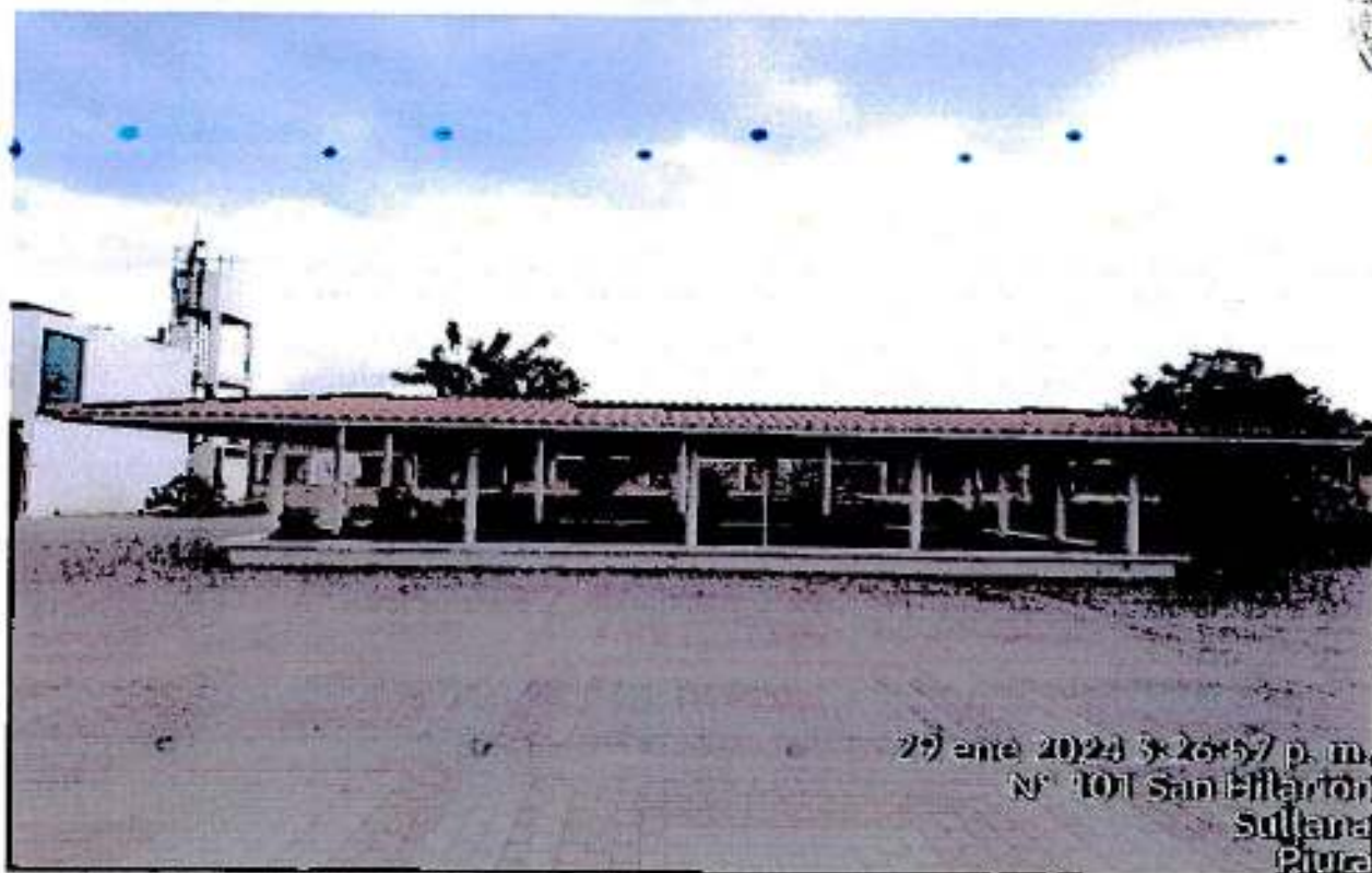
Ilustración 28. SERVICIO DE MANTENIMIENTO DE LUMINARIAS DE PERGOLA DE RECTORADO – CULTURA
