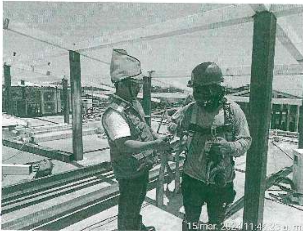
Inspección de contratistas
