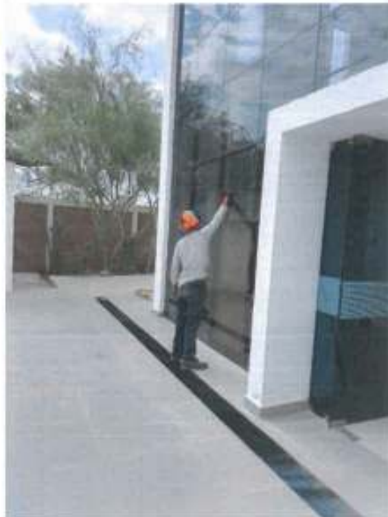
Se realizó la limpieza de ventanas externas
