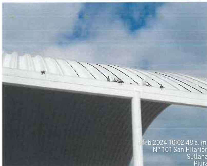
Se verifica la presencia de vegetación y animales en la canaleta.
