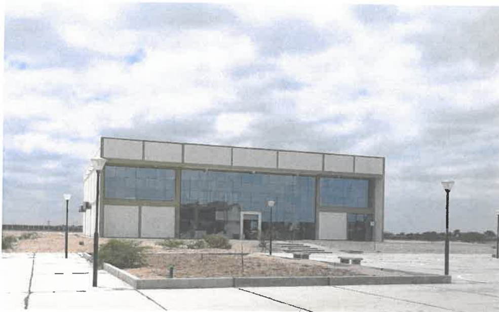
Fotografía 33. Fachada del Taller de Hotelería
