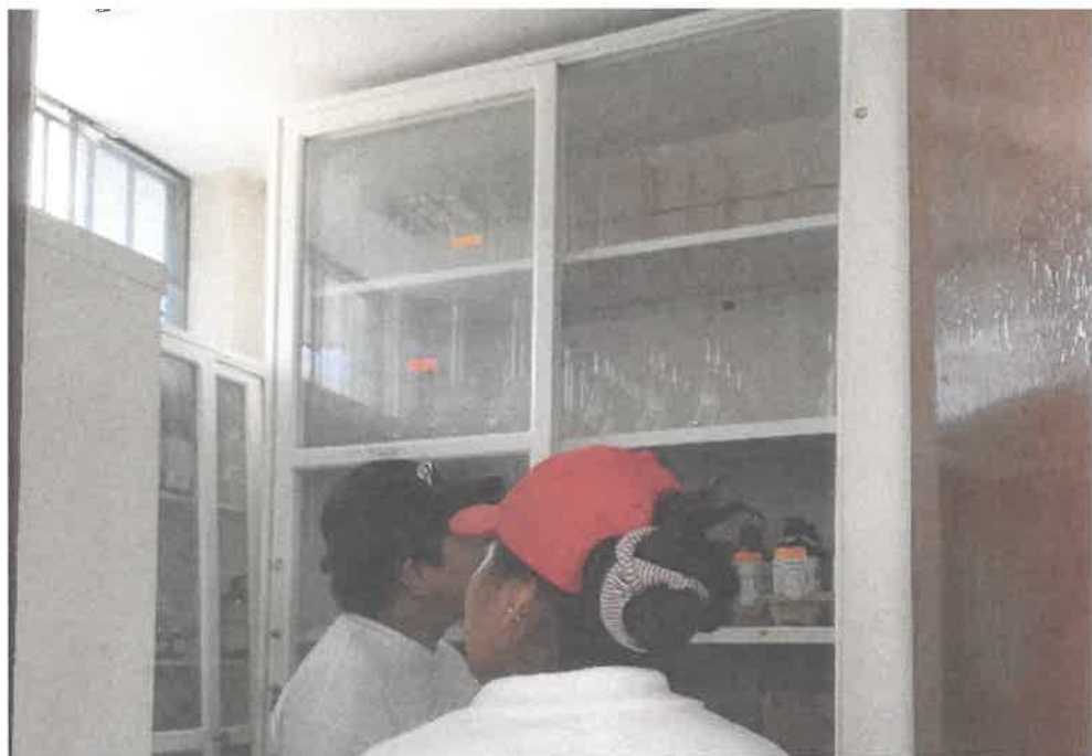
Fotografía 4. Andamio de reactivos sin empotrar (Riesgo de caída de reactivos).
