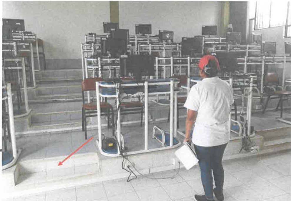
Fotografía 25. Pasadizos estrechos, ausencia de cintas antideslizantes en escalones, ausencia de salidas de emergencia (Riesgo de caídas, golpes, fracturas).
