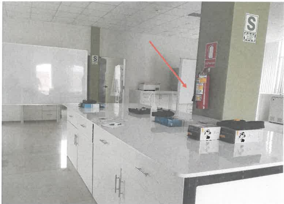
Fotografía 15. Extintor de fuego.
