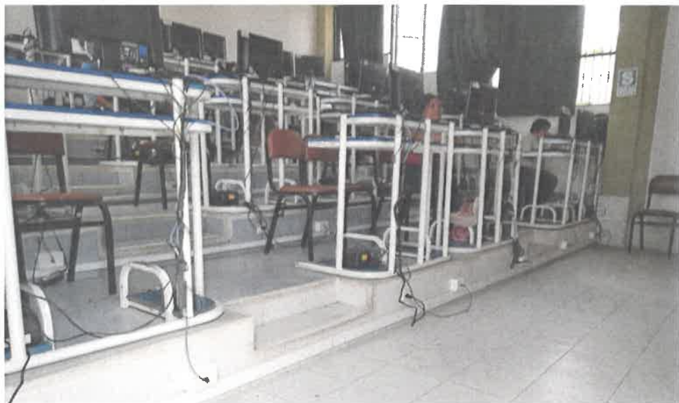
Fotografía 24. Saturación de equipos de cómputo (Riesgo eléctrico, imposibilita la rápida evacuación ante un sismo)
