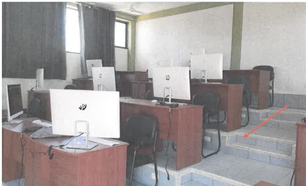
Fotografía 26. Ausencia de cintas antideslizantes (Riesgo de caídas, tropezones)
