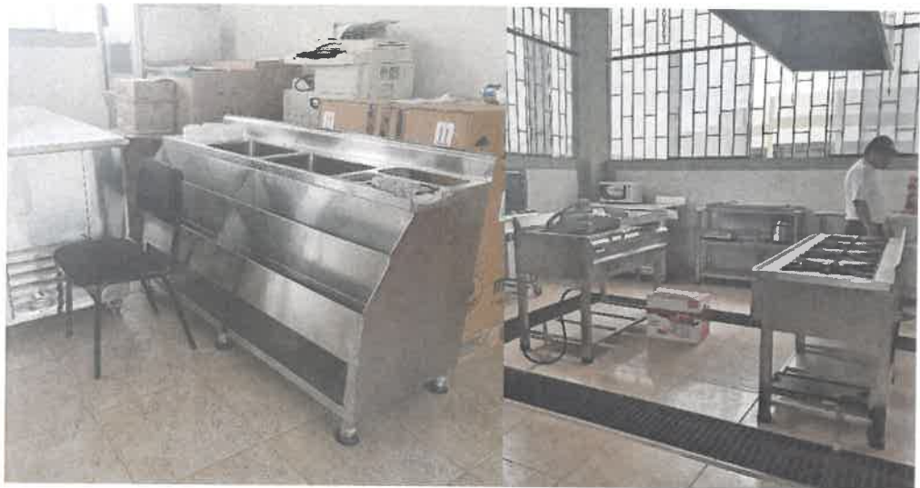
Fotografía 30. Ambiente térmico (Sofocamiento), presencia de equipos: Cocinas industriales, horno industrial, microondas (Riesgo de quemaduras, incendios).
