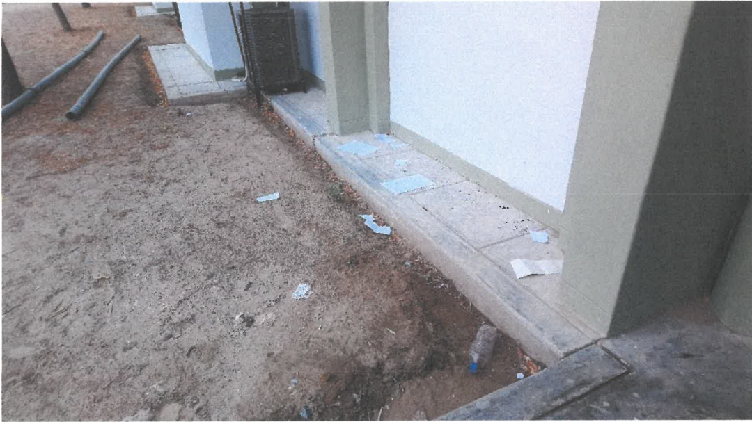
Fotografía N° 11: Parte posterior del módulo de aulas
