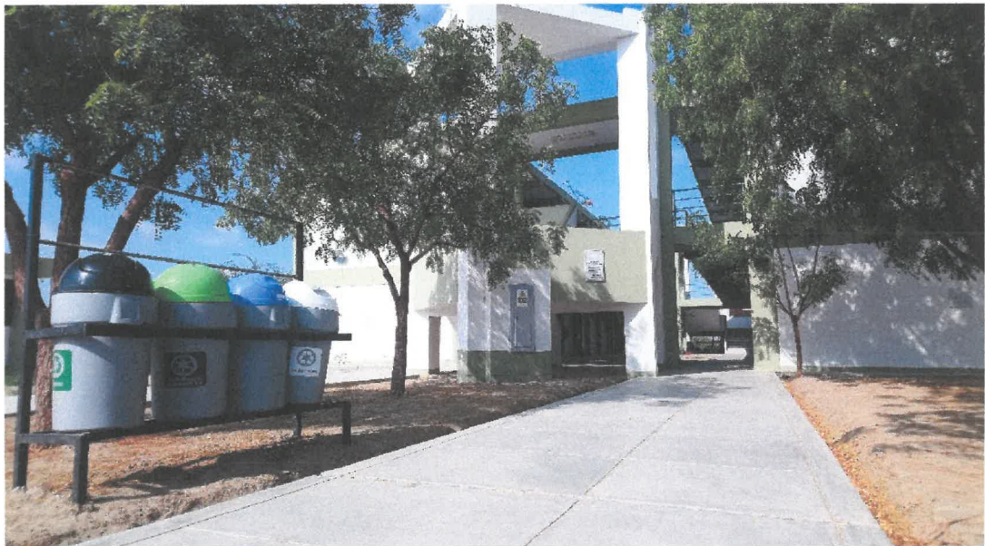
Fotografía N° 09: Módulo de aulas
