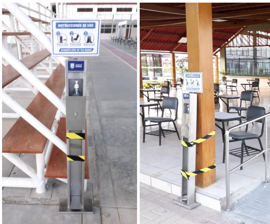
Imagen N° 02. Vista de los dispensadores de alcohol en gel en losa deportiva y hall del cafetín.
