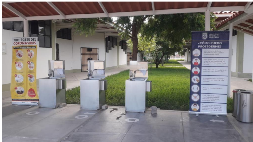
Imagen N° 03. Vista de lavamanos portátiles ubicados entre los pabellones A y B.
