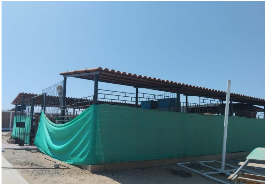
Imagen 4. Centro de acopio de residuos sólidos, en la cual se observa el perímetro
