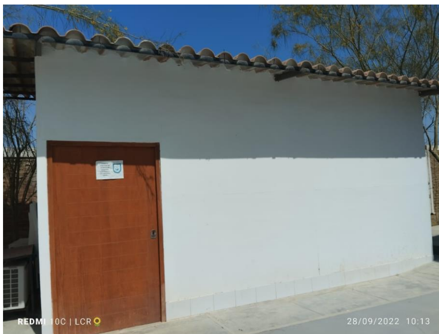
Imagen 10. Caseta de acopio de RAEE
