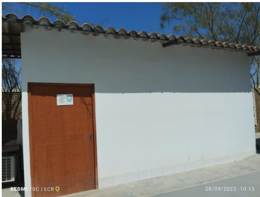
Imagen 4. Centro de Acopio de RAEE
