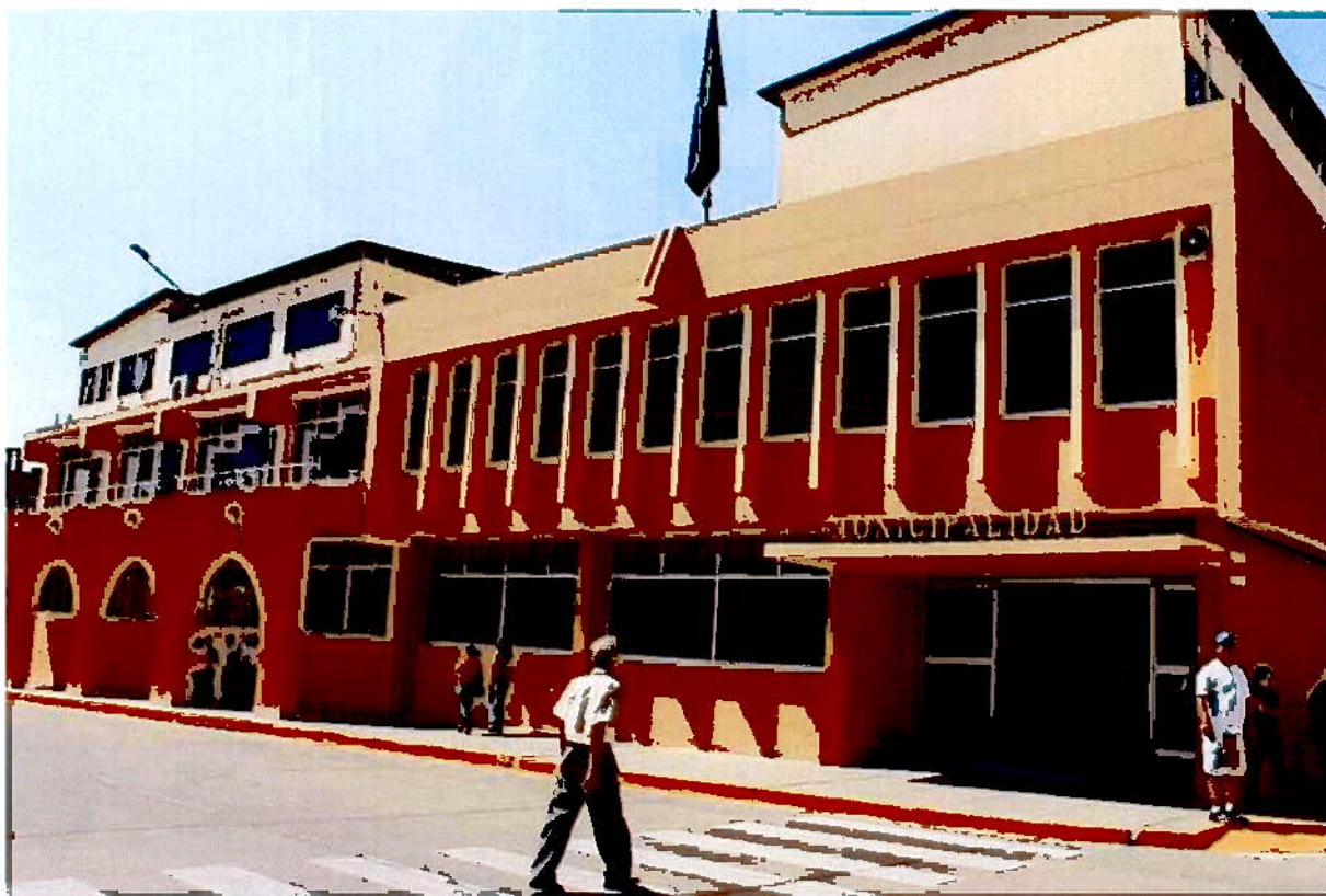
Anexo 02: Panel fotográfico del salón Carlos Augusto Salaverry – Municipalidad Provincial de Sullana
