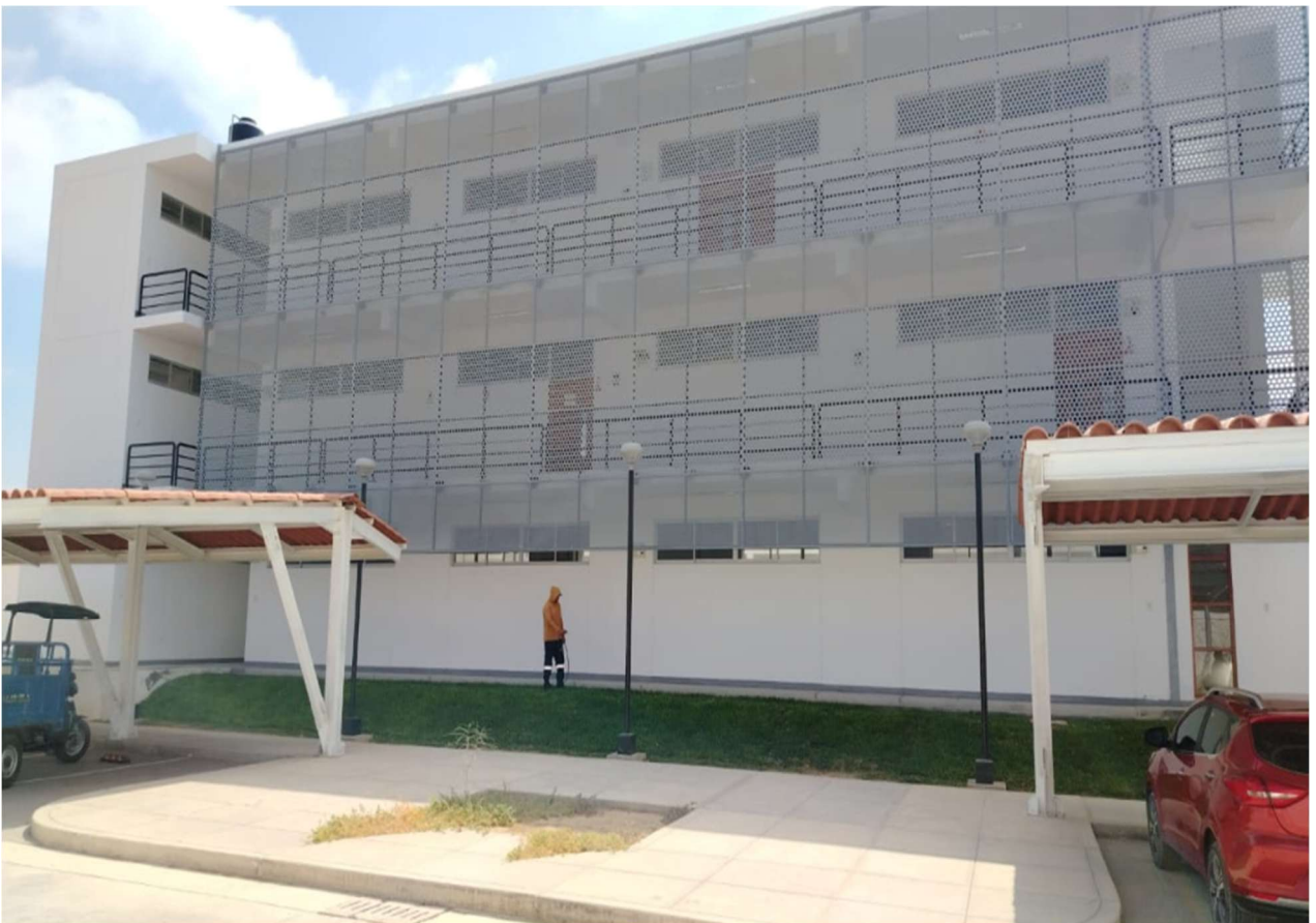
6.01.21 MANTENIMIENTO Y OPTIMIZACION DEL SISTEMA DE RIEGO POR ASPERSION EMERGENTE ROCIADOR PARA EL MANTENIMIENTO DE LAS AREAS VERDES DE PABELLON DE IDIOMAS DE LA UNF
