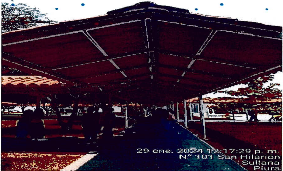
Ilustración 14. SERVICIO DE MEJORAMIENTO DE PINTURA EN ESTRUCTURA DE LA COBERTURA DE LOS ACCESOS PEATONALES EXISTENTES
