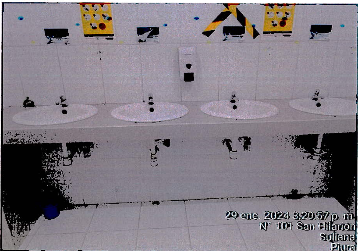
Ilustración 26. SERVICIO DE MANTENIMIENTO CORRECTIVO DE LOS SERVICIOS HIGIENICOS DE RECTORADO
