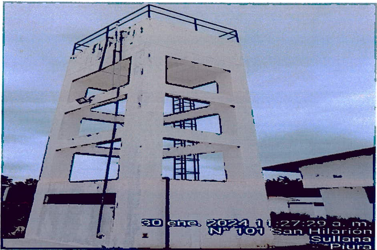
Ilustración 11. SERVICIO DE MANTENIMIENTO DE ESTRUCTURA DE TANQUES ELEVADOS DE LA UNF
