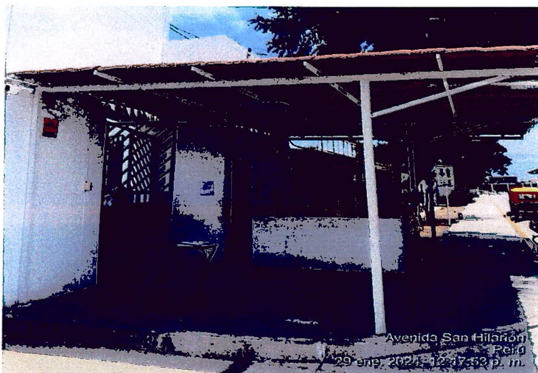
Ilustración 1. SERVICIO DE MANTENIMIENTO CORRECTIVO DE LA CASETA DE VIGILANCIA DE LA GARITA PRINCIPAL DE LA UNIVERSIDAD NACIONAL DE FRONTERA
