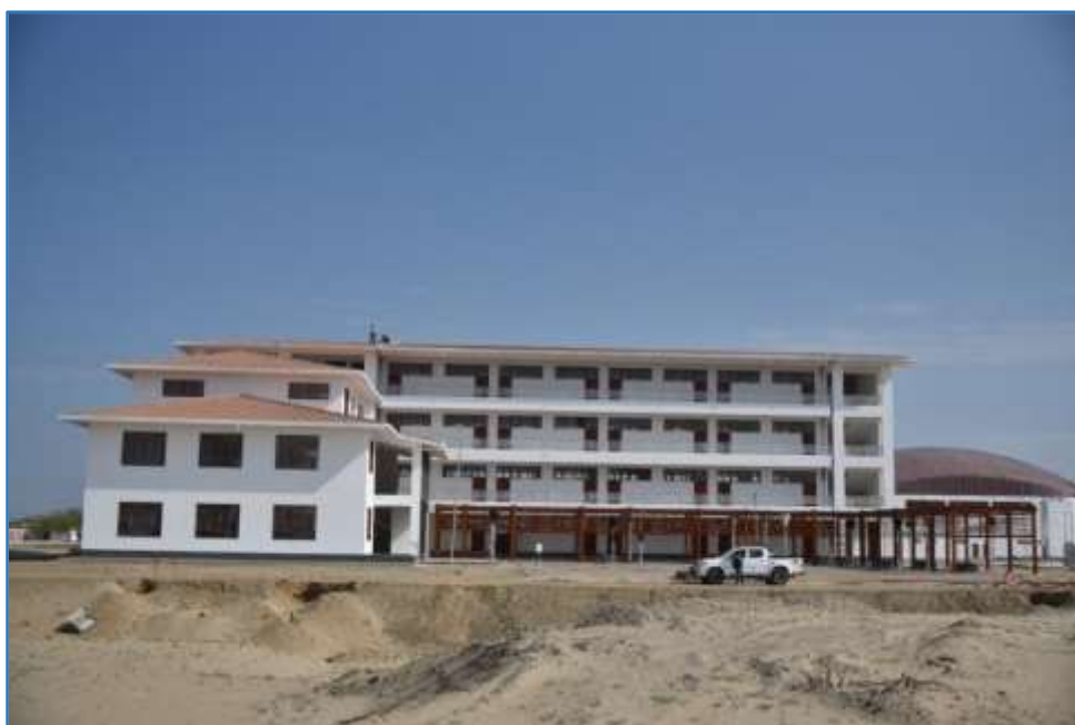
Obra de Pabellón de Aulas casi culminada
